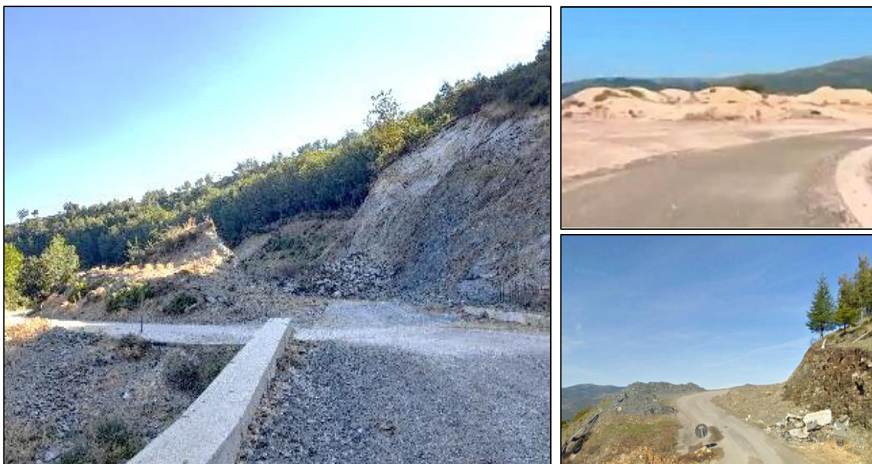
Fig.re 17.18.19 _ Stato attuale piazzole, sbancamenti.
