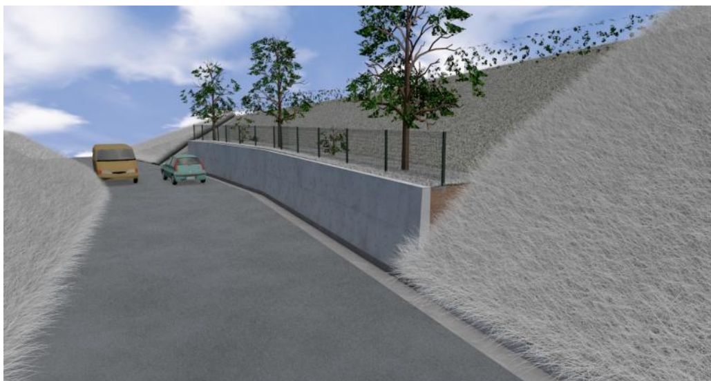
Fig. 16 _ Tipologia barriere di contenimento ( Realizzazione di new jersey in opera)
