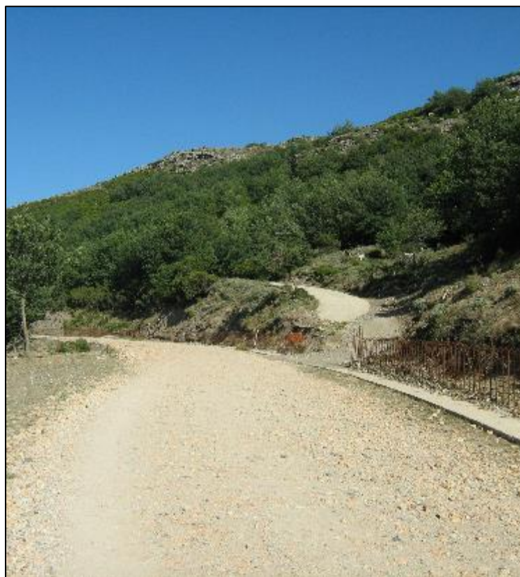
Fig. 6 _ Stato di fatto sovrastruttura stradale _ adeguamento/completamento barriere
