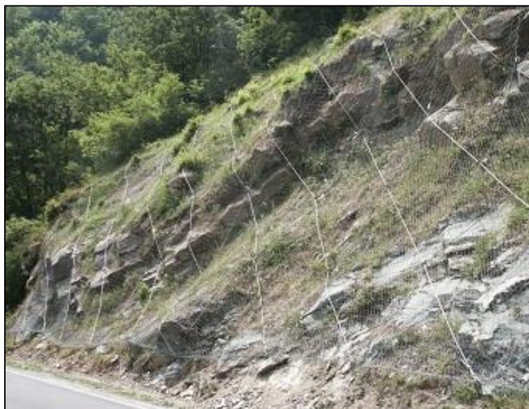
Fig.ra 12_ Tipologia consolidamento versanti
